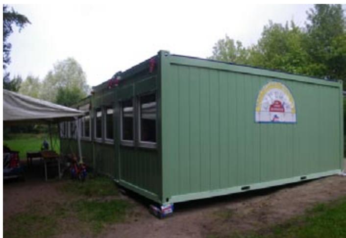
Die nun komplette Containeranlage
