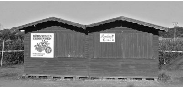
Dieses „Gebäude“ wird den fliegenden Bauten zugeordnet und ist kein privilegiertes Bauvorhaben.
